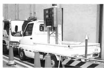
東京都市ヶ谷の商店街に隣接した住宅街での下水道工事現場では、トラックの荷台に載せ、移動しながらでも測定値を表示しています。
