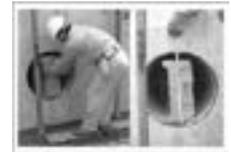
地下ビット工事で壁・スラブ施工後、人通路やマンホールから搬出入できます。
