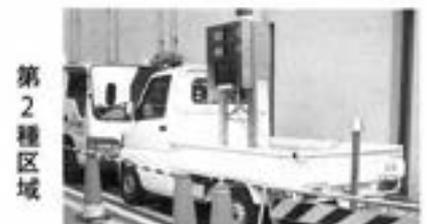
東京都千代田区の商店街に隣接した住宅街での下水道工事現場では、トラックの荷台に載せ、移動しながらも測定値を表示しています。
