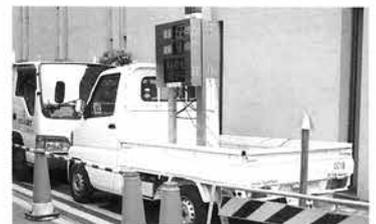
東京都千代田区の商店街に隣接した住宅街での下水道工事現場では、トラックの荷台に載せ、移動しながらでも測定値を表示しています。
