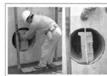
地下ビット工事で壁・スラブ施行後、人通孔やマンホールから搬出入できます。
