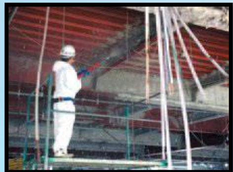
ロックウールの除去
